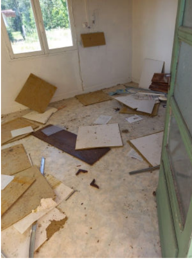
Le faux plafond
